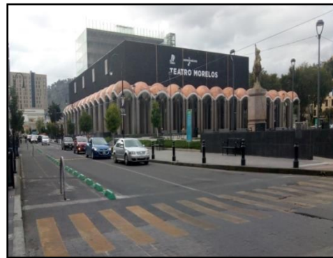
Imagen No. 26 Alumbrado Público, Av. 5 de Mayo Oriente
